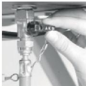
**7** Установите ручку на клапан и поверните ее вверх на 90 градусов, таким образом обеспечив слив воды из бойлера.
